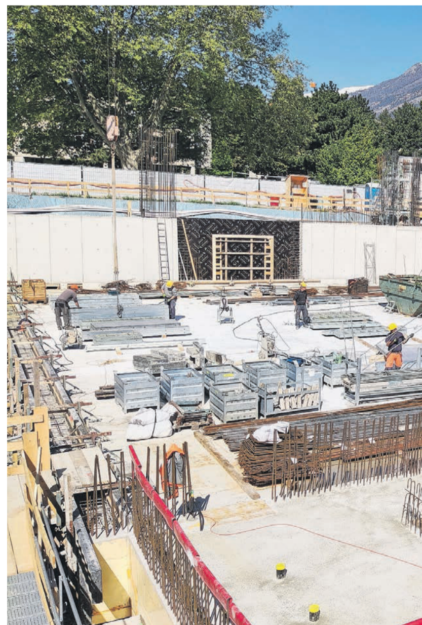
Mehr Raum für Wohnungen und Schüler in Visp: die Überbauung «Litterna» (ob)
