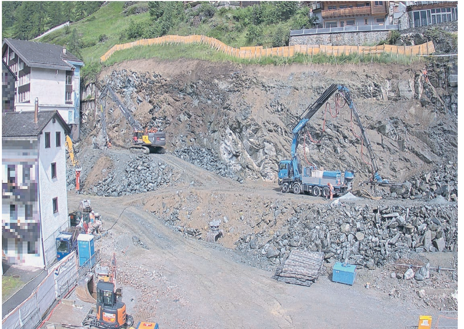
Die Bauarbeiten für das neue Zermatter Schulhaus sind seit diesem Frühling im Gang.
